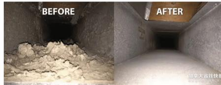
管道清洁一般指清理冷暖通风系统的各个风管部分，包括出风和回风管道，风口，热交换器，风扇电机等，是节省冷暖气设备能源消耗的最佳途径。除此以外，管道清洁还可以显著提高室内空气质量，阻断不明过敏原，清除有害病菌，这在疫情愈发严重的寒冷冬季就显得尤为重要。
