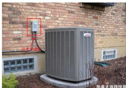
空调的调节电路一般都在空调主机附近。通常是一个带盖的塑料或者金属盒子的样式。关闭电路也很简单，打开盖子轻弹开关关闭即可。这样可以防止在回暖的冬天空调自动打开运行，机器进水损坏。
