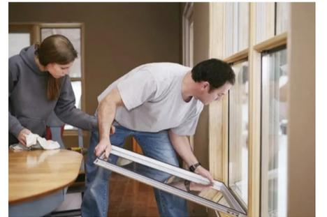
Storm Door/Storm Window 是指在原本的门 / 窗外 (或里) 额外增加的一道门 / 窗，可以有效增加密封保暖的效果，提升能源效率达 45%。当然，觉得防风暴门窗太贵的话，也可以考虑简单的给窗户内里加一层透明的密封膜，不会影响视野但同样也有一定的保温效果哦！
