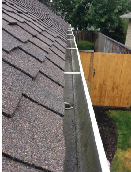
加拿大的冬天十分漫长，入冬前一定要检查自家的屋顶，如果沥青片/瓦片有任何破损要及时修补，防止发生漏水的现象。如果要更换屋顶，也请在入冬前做好，一般情况下普遍使用到的沥青瓦片需要一定的温度才能在铺好后短期粘合牢固，冬天温度过低，会影响工程质量，而且也有可能因为气候变化太大，影响工程进度。
