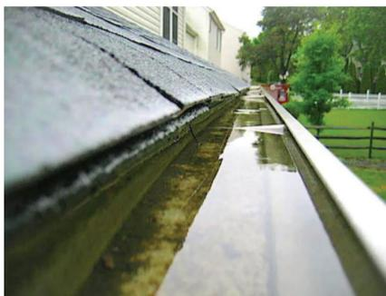
首先要做的是检查下水管，尤其是你的家前后院有树的话，落叶会堵塞下水管，导致水分积聚，有可能损坏房屋。如果有水渍的话，可以使用漂白剂和水的混合物去除渍。
