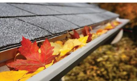
下雨的时候可以留意排水槽是否畅通，当水槽堵塞时，树叶和碎屑会积聚在水槽内，这些水会渗入屋檐和木瓦下，并渗入房屋的墙壁。严重堵塞的水槽也可能使房屋在某些地方变形或与房屋分离，
