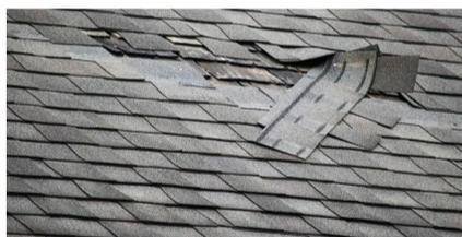
看看屋顶是否有塌陷，缺瓦，起翘等老化现象。如果屋顶寿命已经超过十年，可以考虑更换屋顶。由于屋顶的材料是沥青瓦片，夏季温度高，日照时间长，新换的屋顶会更加贴合，严丝合缝，能有效的把雨水阻隔在外。
