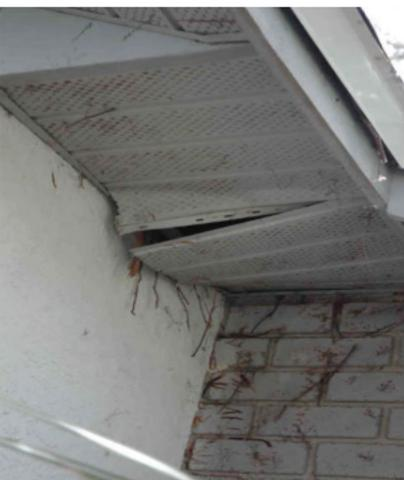
及时修复变形，飞走的墙身和扣板。避免雨水直接接触到房屋的木结构，导致木板软烂，发霉，变形等
