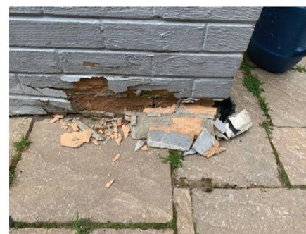
雨水会顺着缝隙或者破损的砖块表面流进地基，日积月累，会导致严重的地基侵蚀。
